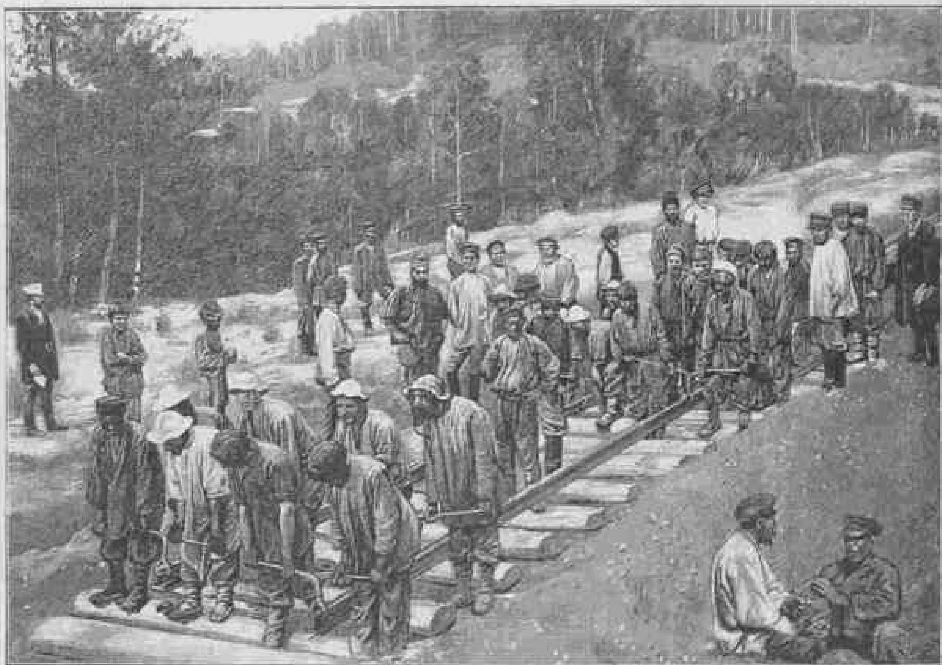
Укладка пути в трех верстах от станции Златоуста.
