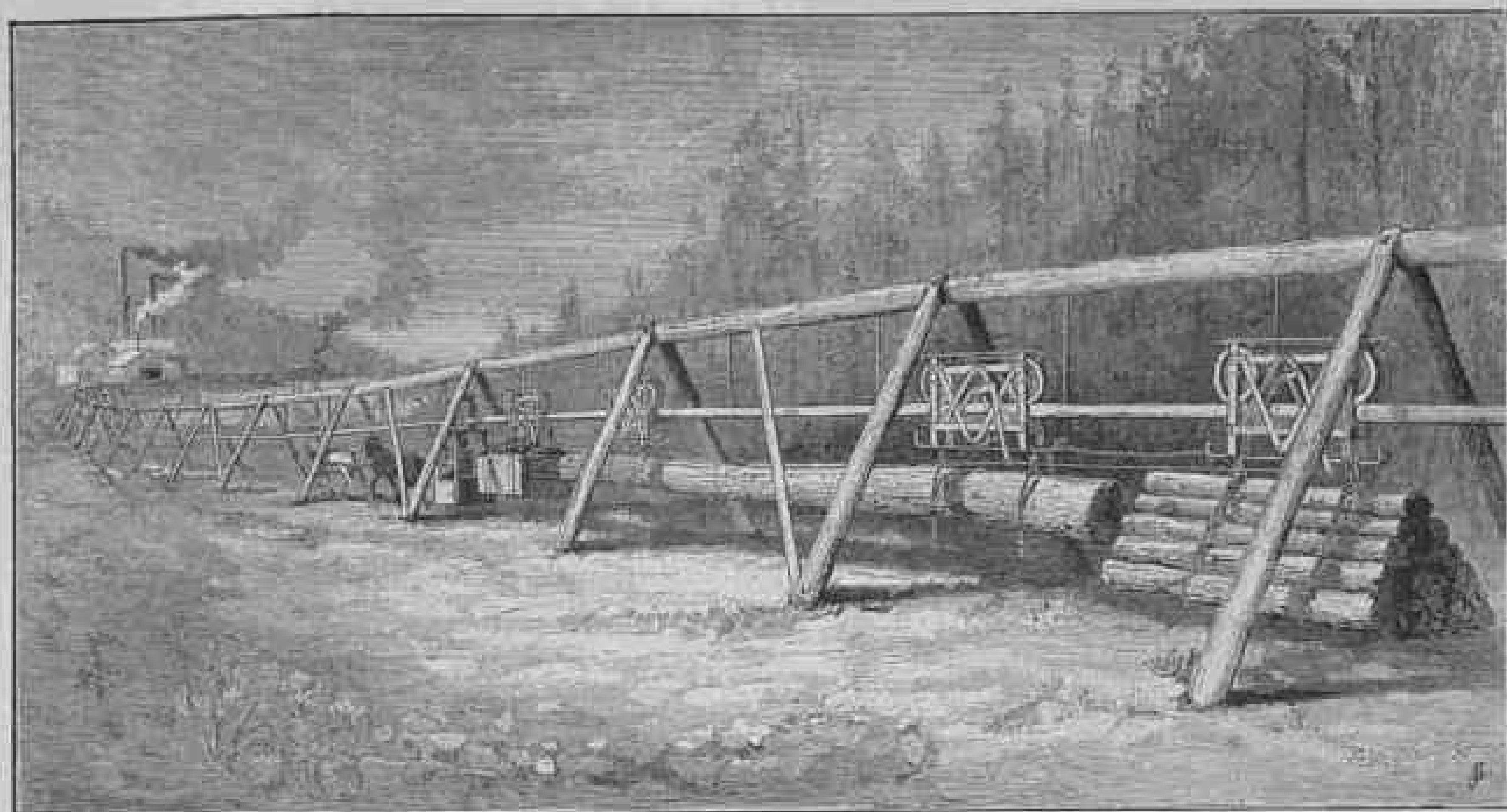
Изъ области политехники. — Желѣзная дорога въ американскомъ лѣсу системы Валлея.
